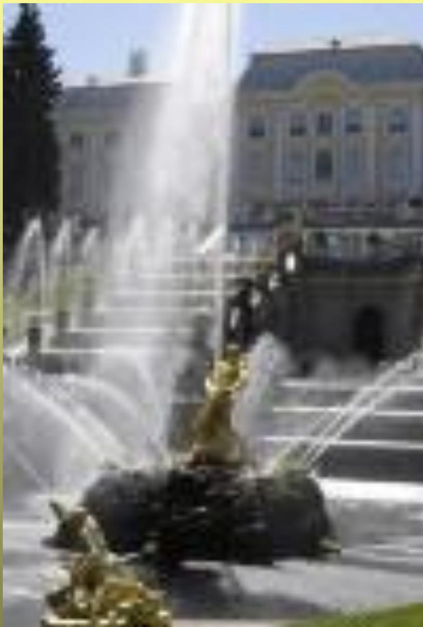
Фонтаны работают без насосов и сложных водонапорных сооружений. Используется принцип сообщающихся сосудов – разница в уровнях, на которых расположены фонтаны и пруды-хранилища.
