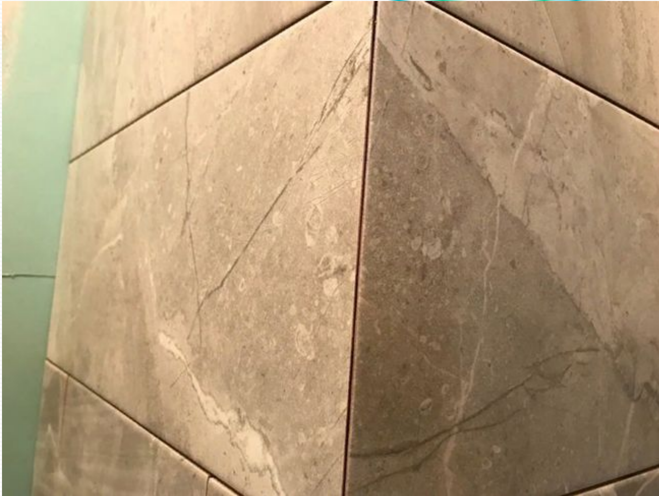
Облицованный угол, плиткой, срезанной под 45 градусов
