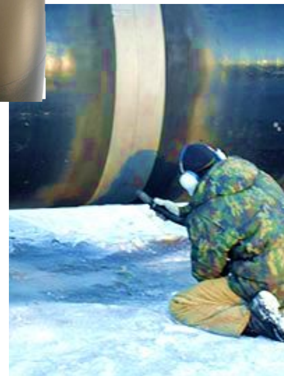
Рисунок 10 – Нанесение термоусаживающих манжет
