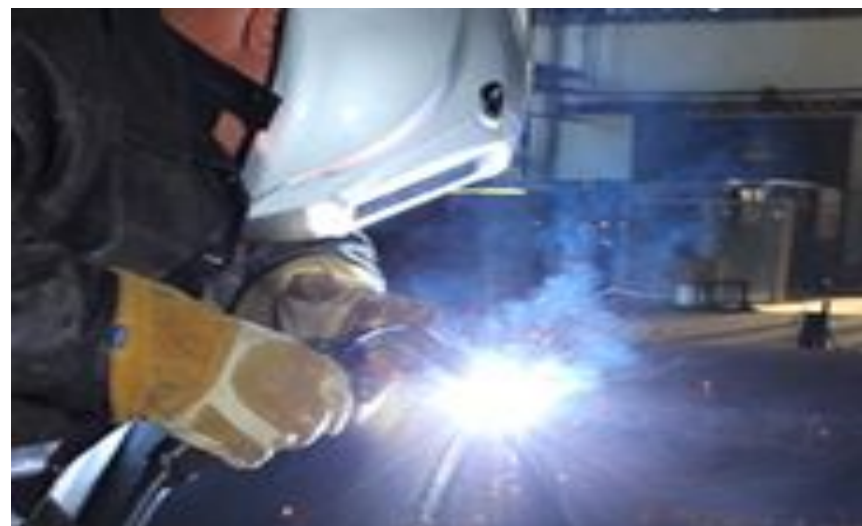
Выборка металла до дефекта сварного шва с последующим удалением и заваркой при ремонте «заваркой»
