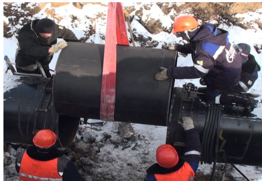
Вварка трубной катушки
