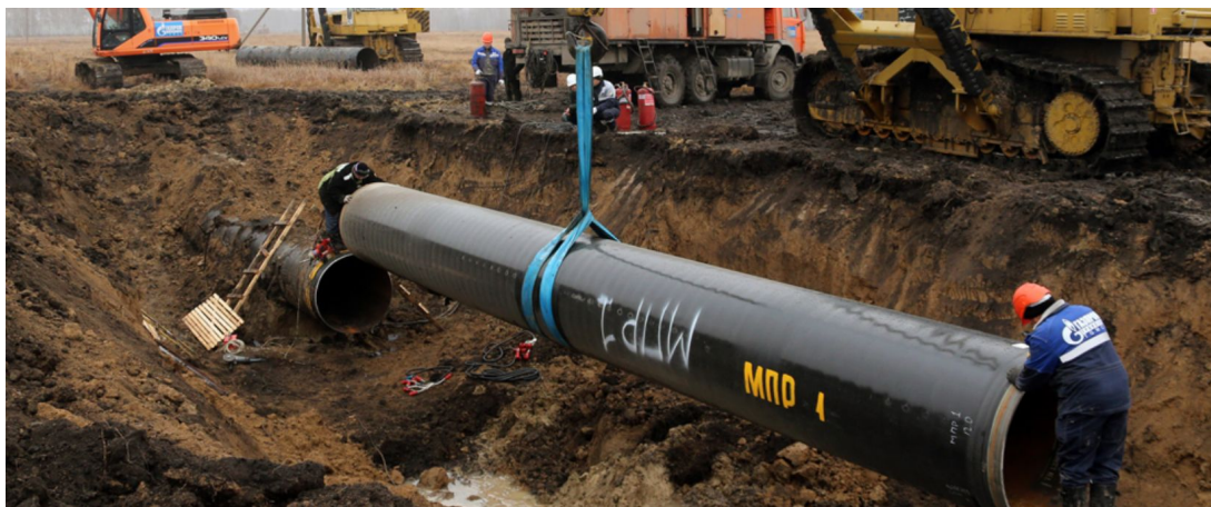
Ликвидация технологического разрыва на газопроводе
