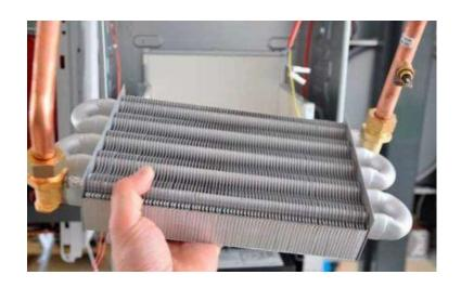
Чтобы снять теплообменник нужно сначала отсоединить датчик перегрева, затем извлекается камера сгорания. Для этого предварительно выкручивают три самореза, после чего камеру вместе с колпаком тянут на себя. После чего осуществляется открепление колпака от камеры и отсоединение теплообменника.
