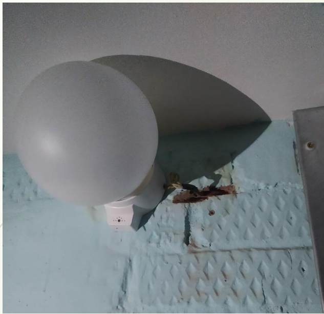
Неизолированная проводка
