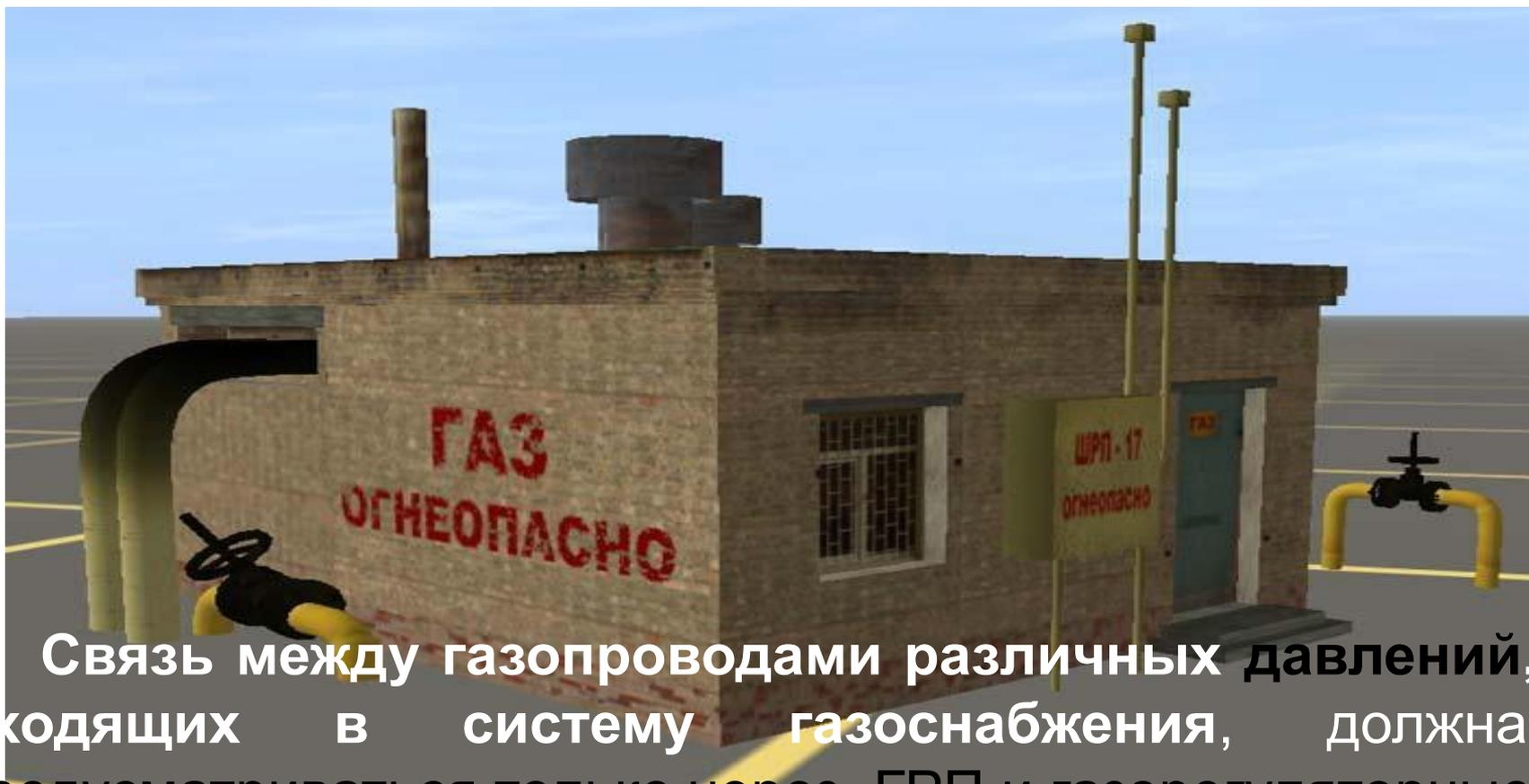
Связь между газопроводами различных давлений, входящих в систему газоснабжения, должна предусматриваться только через ГРП и газорегуляторные установки (ГРУ).
