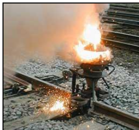
Термитная сварка
