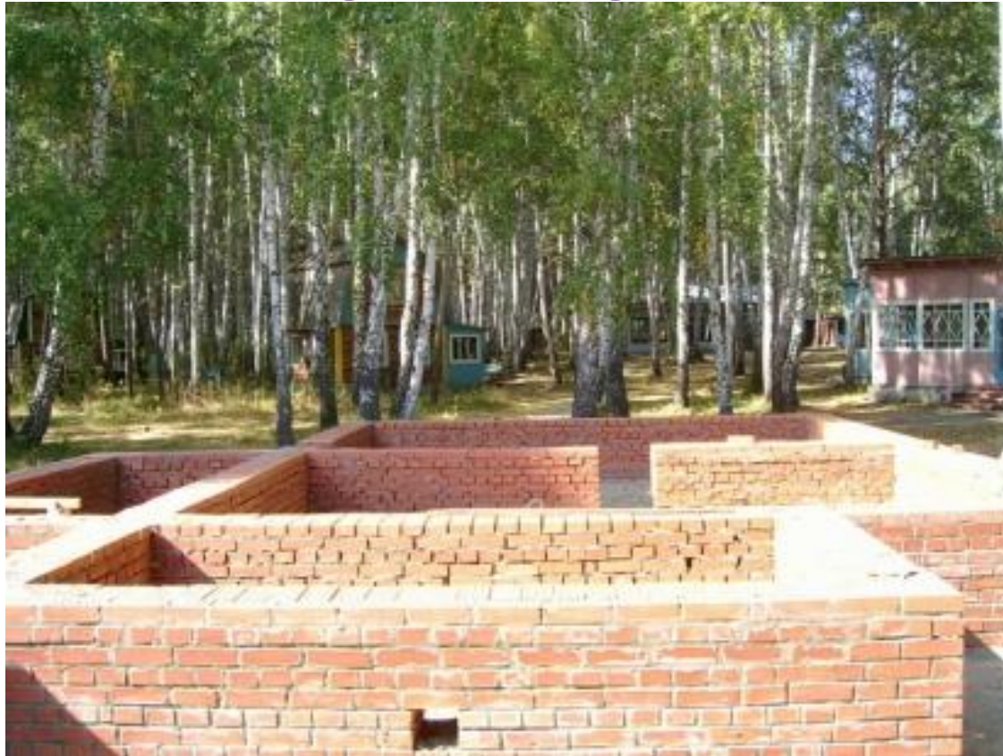
Закладка фундамента здания
