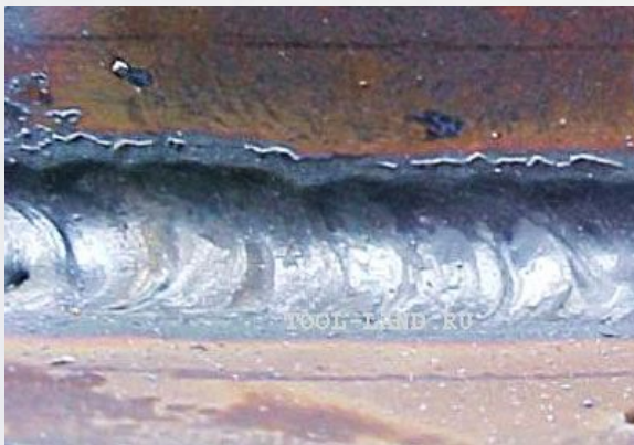
Прерывистый односторонний подрез стыкового сварного шва
