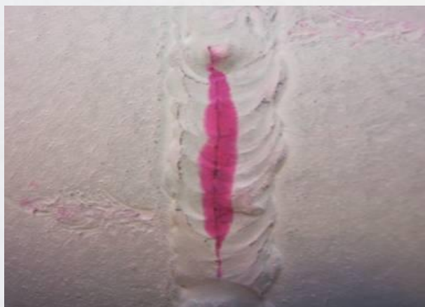
Индикаторные следы дефектов при проведении цветного метода ПВК
