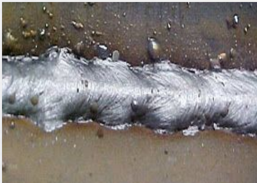
Неравномерная ширина и неровная поверхность шва
