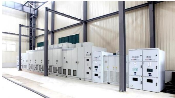
Высоковольтный инвертор мощностью 12 МВт для первой испытательной станции ядерных насосов в Шанхае Apollo
