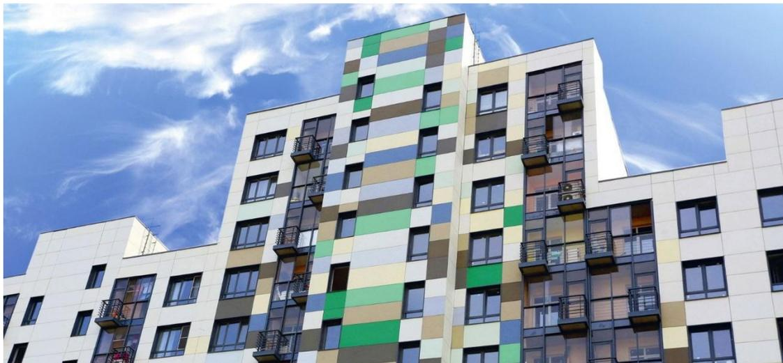
**СОСТАВ:** Содержит 90% цемента и 10% целлюлозной фибры в сочетании с минеральными добавками для получения максимальной механической прочности при сохранении небольшого веса плит.
