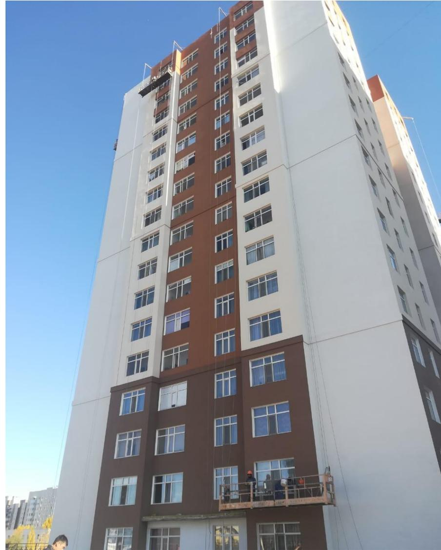
**СОСТАВ:** Минеральные плиты закреплены клеем и дюбелями. Поверх армирующей сетки нанесена цементная, декоративная штукатурка и покраска.
