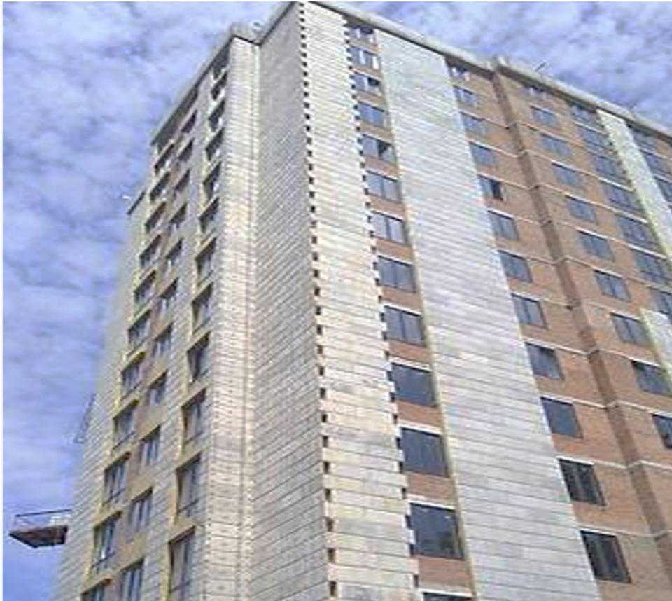
**СОСТАВ:** 1. Декоративный слой: цемент, песок и фиброволокно (20 мм), 2. термоизоляционный слой - пенополистирол.
