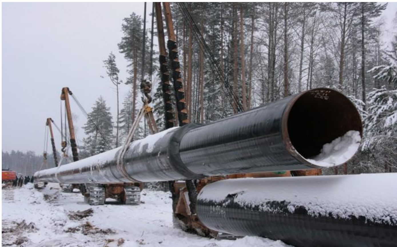
Укладка магистрального газопровода
