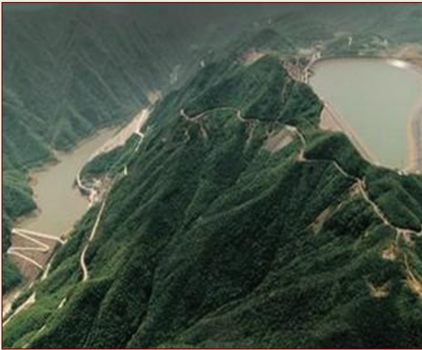
ГАЭС Tiahuangping с подземным зданием, Китай. Общий вид
