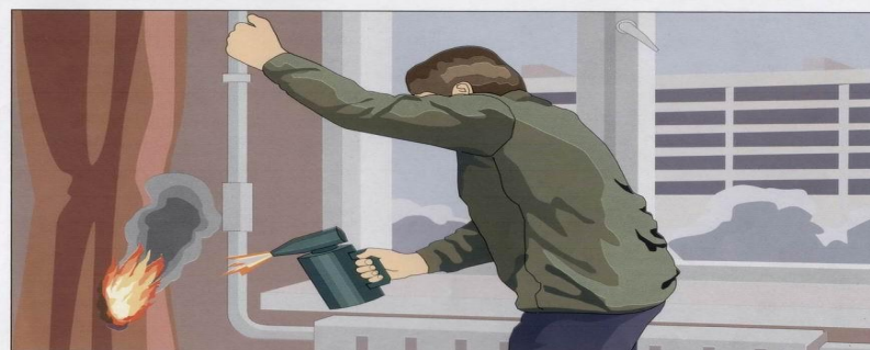
Отогревание замёрзших труб паяльными лампами и факелами
