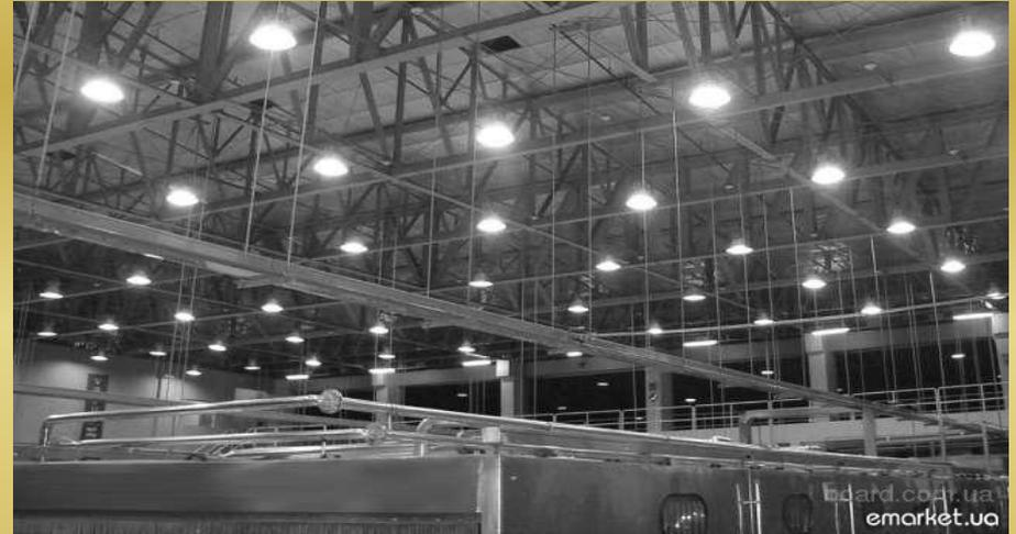
Искусственное освещение обеспечивается системами *общего* или *комбинированного* освещения. Общее освещение подразделяется на общее равномерное, которое устраивается без учета расположения рабочих мест, и общее локализованное, при котором размещение светильников связано с расположением оборудования и рабочих мест. При первом – высота подвески светильников, тип светильников, мощность ламп и т.д. принимаются одинаковыми, при втором – перечисленные характеристики могут быть различными.
