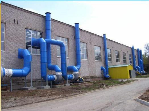
Системы *общеобменной вентиляции* для производственных и административно-бытовых помещений без естественного проветривания следует предусматривать не менее чем с двумя приточными или двумя вытяжными вентиляторами каждая с расходом по 50 % требуемого воздухообмена. Допускается предусматривать одну приточную и одну вытяжную системы с резервными вентиляторами.
