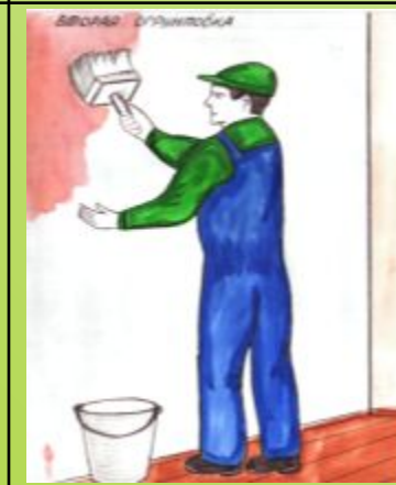
Вторая огрунтовка поверхности
