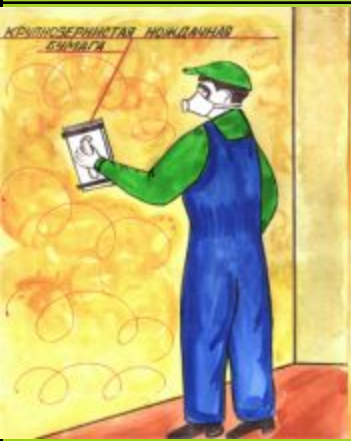
Первое шлифование поверхности
