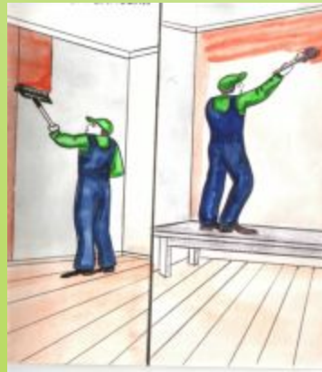
Первая огрунтовка поверхности
