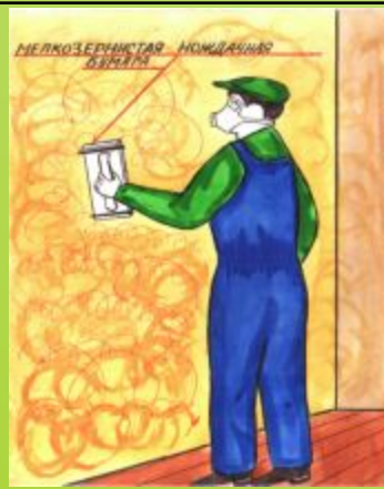
Второе шлифование поверхности
