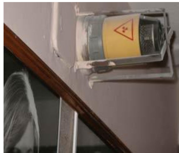
Рис. 10 – Первый ионизационный дымовой извещатель
