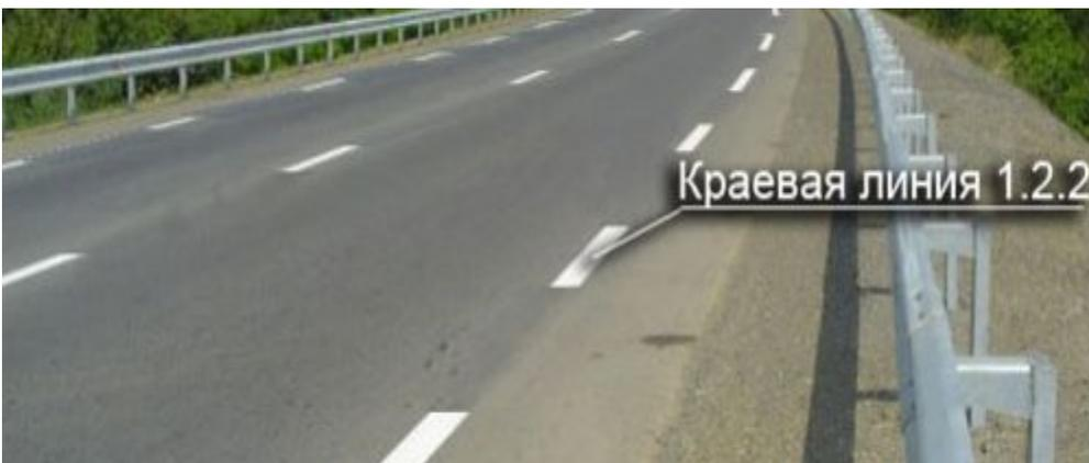
Всё содержание Правил должно соответствовать ГОСТу. ГОСТ Р 52289 – 2004 в частности допускает использовать в качестве краевой линии не только сплошную, но и ПРЕРЫВИСТУЮ линию разметки при соблюдении следующих обязательных условий:
