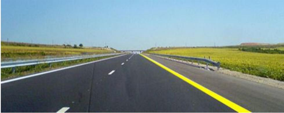
При отсутствии бордюра сплошную жёлтую линию могут нанести вместо краевой линии, которая отделяет проезжую часть от обочины. В данной ситуации на всём протяжении сплошной жёлтой линии **запрещена** остановка транспортных средств (как на проезжей части, так и на обочине). В тех случаях, когда требуется ввести запрет не на остановку, а только лишь на стоянку, применяют прерывистую жёлтую линию.
