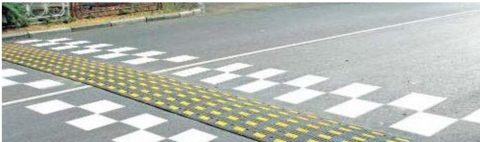
**Если такой возможности нет, ГОСТ допускает наносить разметку до и после искусственной неровности.**
