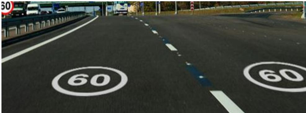
А сейчас разметка на проезжей части дублирует действие запрещающего знака 1.24 «Ограничение максимальной скорости». Обратите внимание – если дорога многополосная, символы нанесут на каждой полосе движения.
