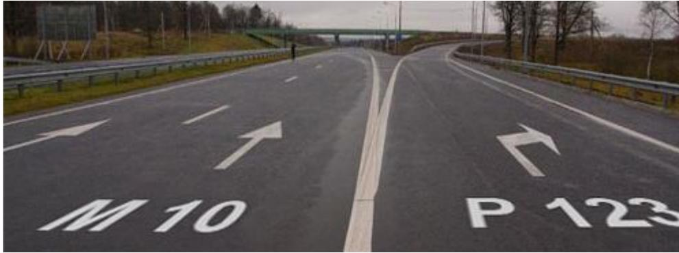
Помимо надписей «СТОП» и буквы «А» на проезжей части может быть нанесена ещё одна надпись – номер дороги (маршрута), утверждённый в установленном порядке. Такую разметку наносят посередине каждой полосы движения, соответствующей направлению дороги (маршрута), как перед перекрестком, так и за ним. При этом перед перекрёстком вместе с номером дороги будет нанесена ещё и разметка 1.18 – стрелы, показывающие направление движения по полосам.
