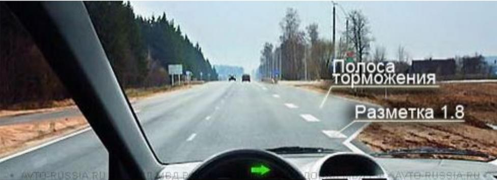
Кроме перечисленных выше линий есть ещё одна прерывистая линия разметки, применяемая в тех случаях, когда дорогу оборудуют полосами торможения или полосами разгона.
