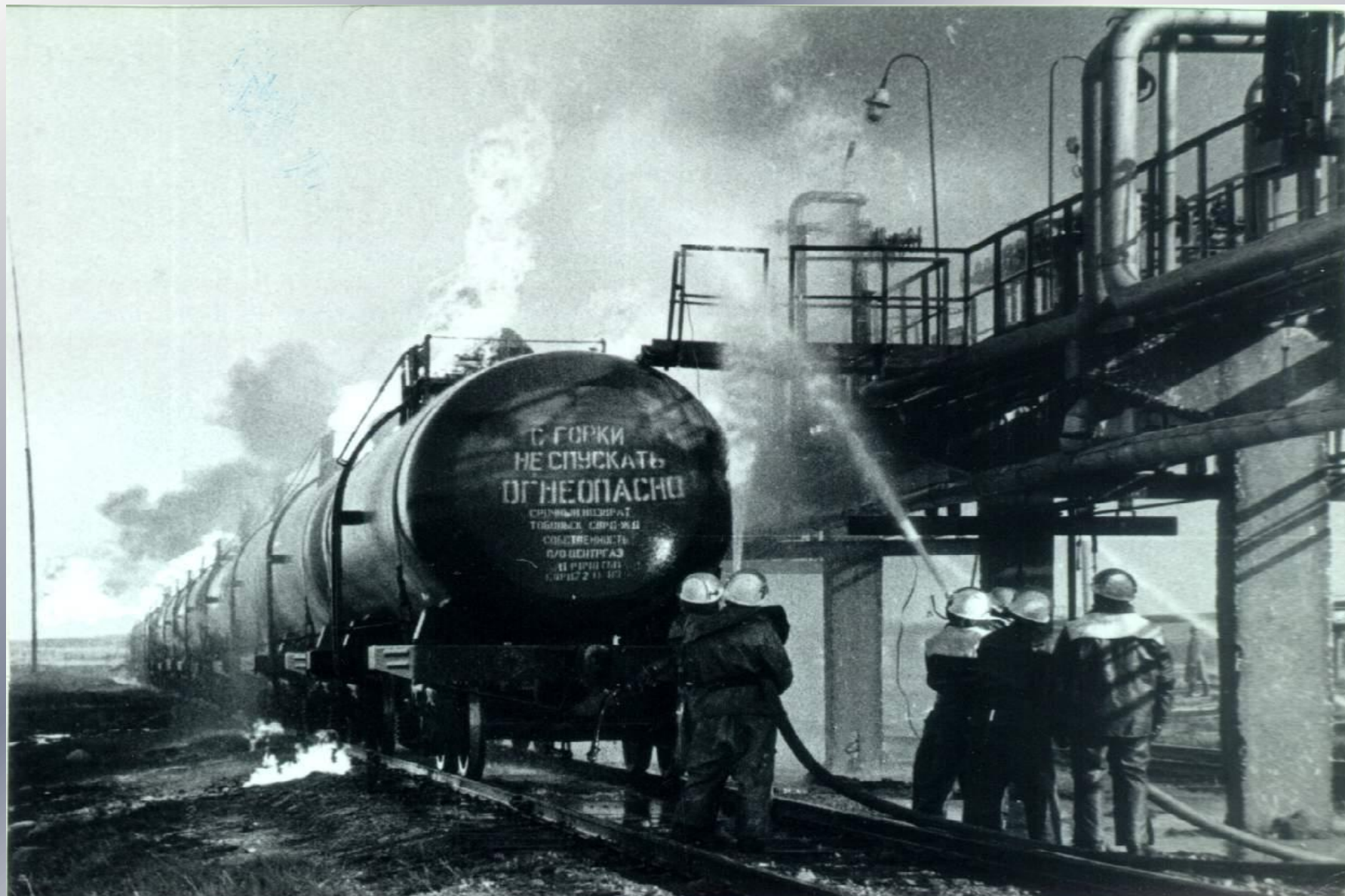
Тушение пожаров на сливной эстакаде
