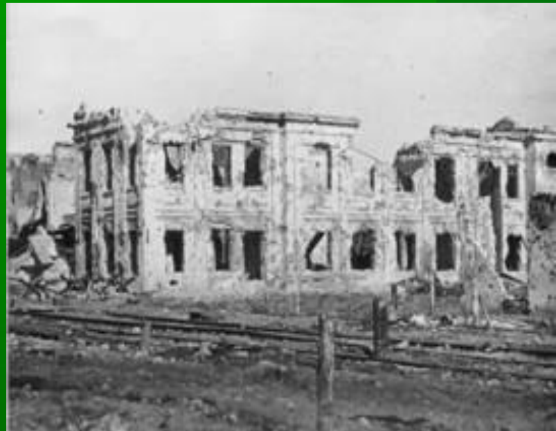
Руины на месте жилых домов
