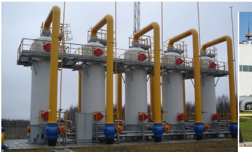
Рис. 2.5. Блок очистки газа с циклонными пылеуловителями
