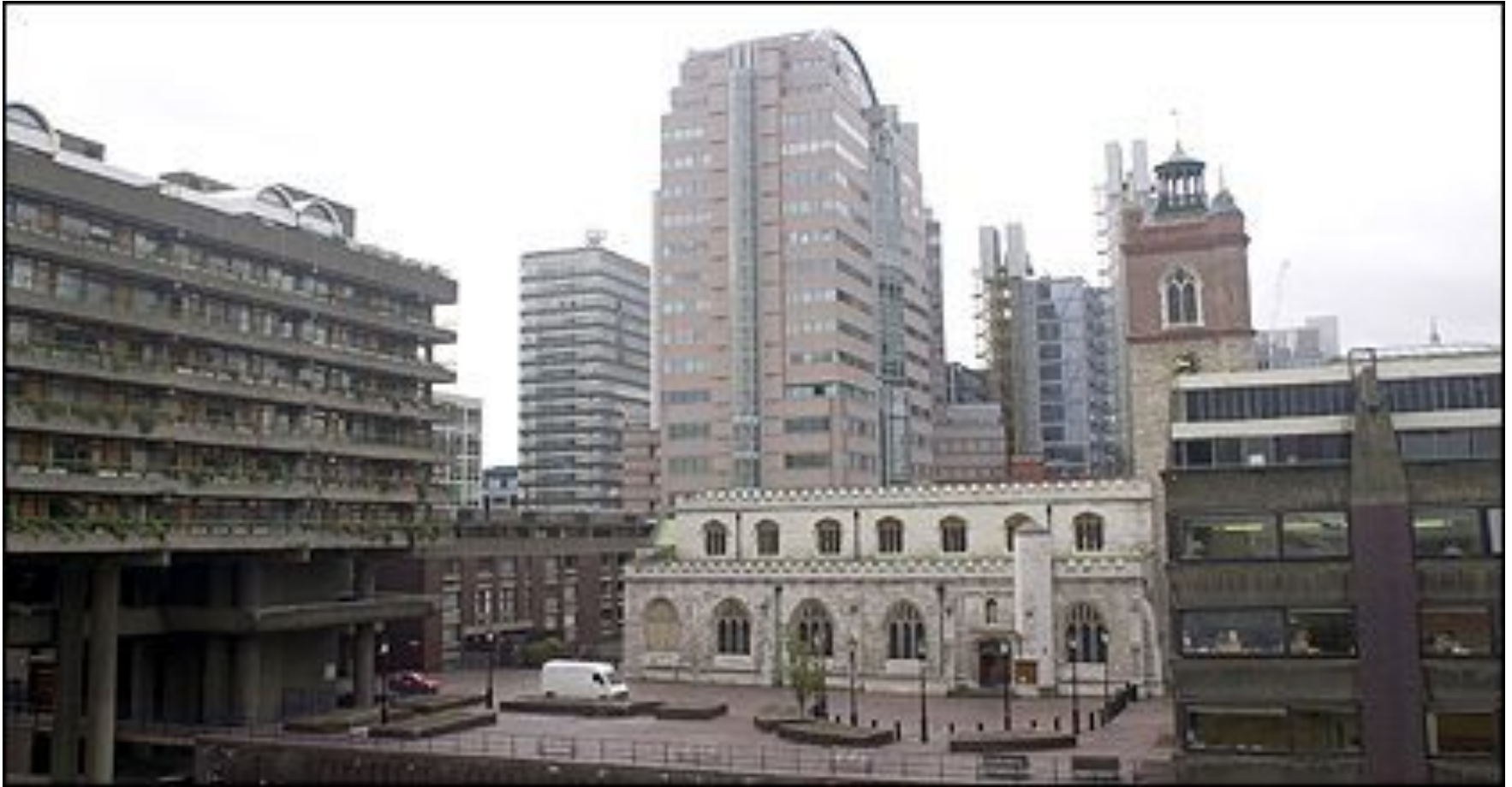
ЖИЛОЙ И ОБЩЕСТВЕННЫЙ КОМПЛЕКС БАРБИКАН В ЛОНДОНЕ.
