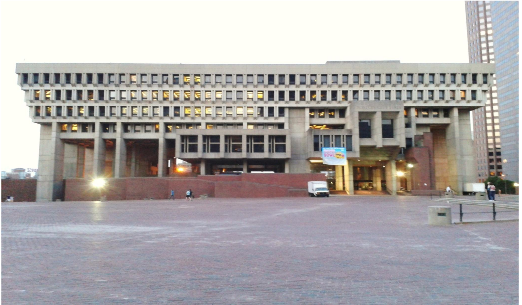
БОСТОН СИТИ ХОЛЛ, 1981, БОСТОН, МАССАЧУСЕТС, США. АРХ-РЫ: Г. КАЛЬМАН, М. МАК-КИННЕЛЬ, Э. НОУЛС
