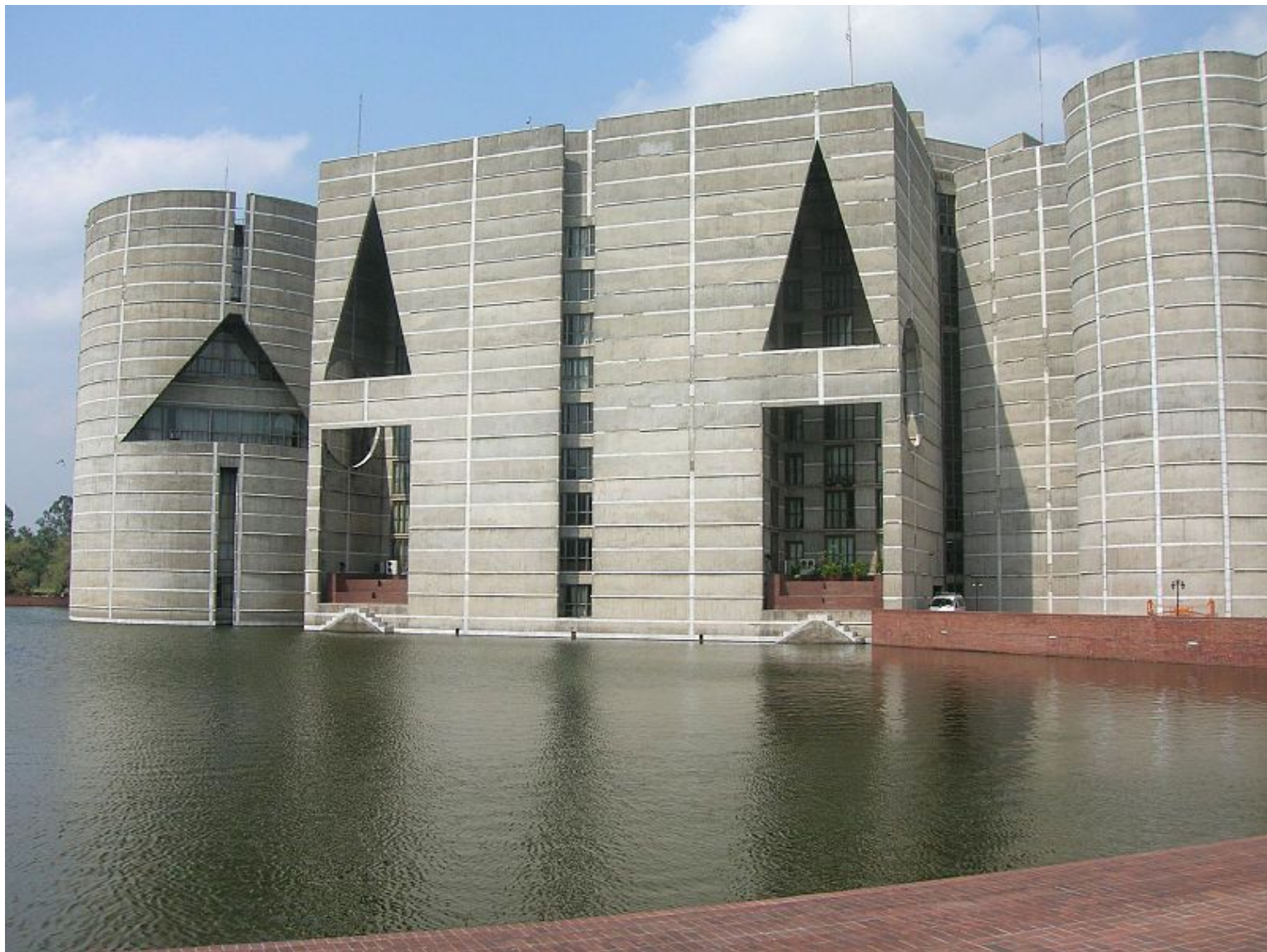
ЗДАНИЕ ПАРЛАМЕНТА В ДАККЕ БАНГЛАДЕШ, 1961. АРХ. ЛУИС КАН
