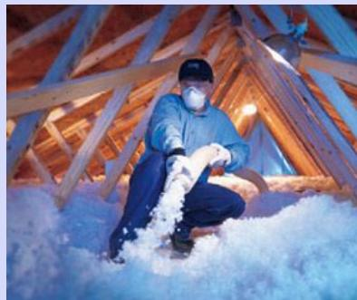
**ШЛАКОВАЯ ВАТА** – материал, состоящий из тончайших волокон, получаемых из огненно – жидких шлаков дутьевым способом – применяется как теплоизоляционный материал.
