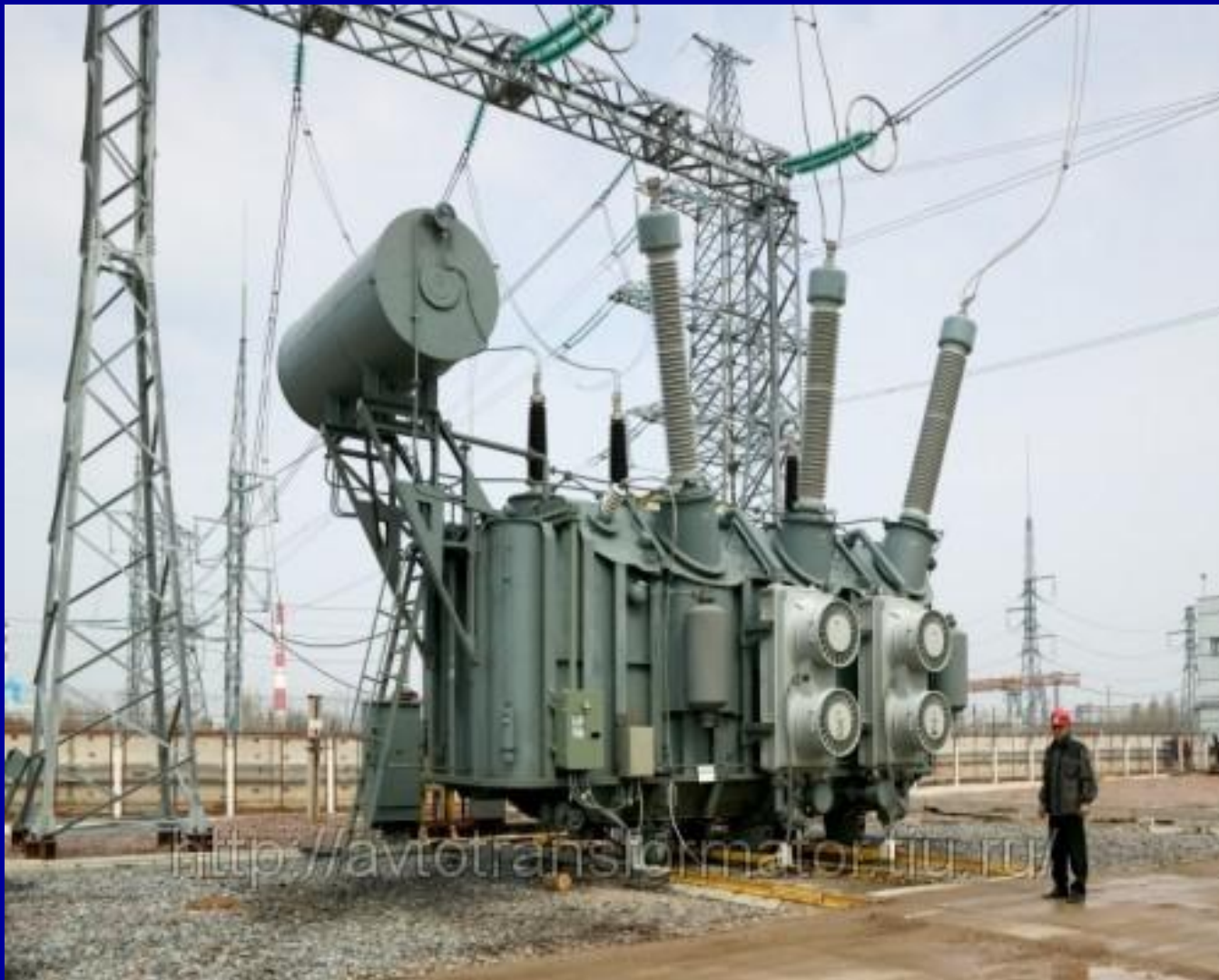
Силовой трансформатор
