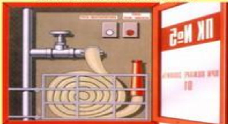
ВНУТРЕННИЙ ПОЖАРНЫЙ КРАН
