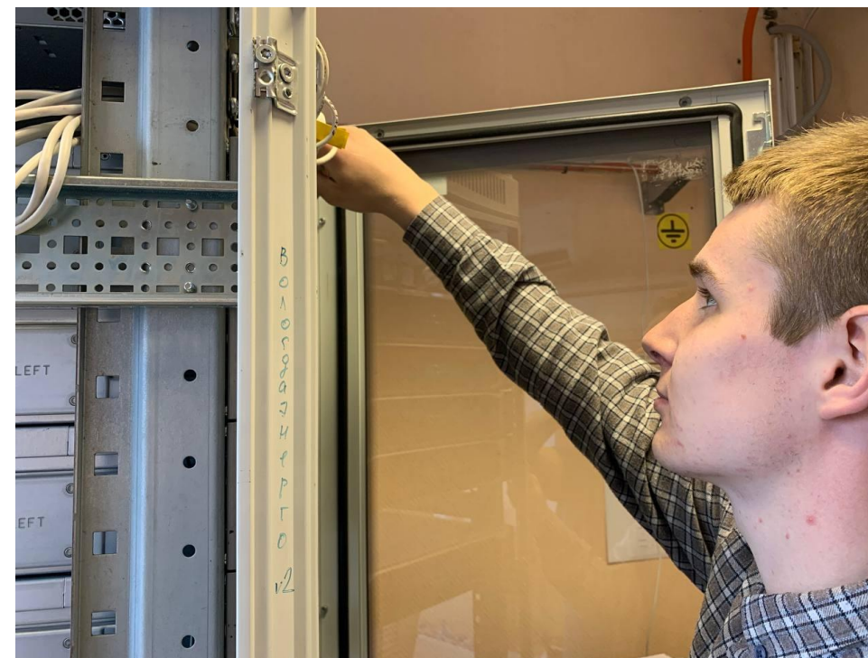
Рисунок 2. Подключение сетевой розетки к коммутатору
