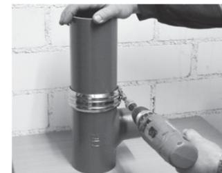
3. Шестигранный винт (imbus) прикрутить при помощи ключа, ручного или аккумуляторного шуруповерта.
