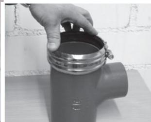
1. Собранные соединение надеть на край трубы или на фитинг до среднего дистанционного кольца, отделяющего уплотнитель
