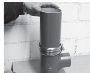
2. Конец следующей трубы или фитинг вставить в соединитель с противоположной стороны.
