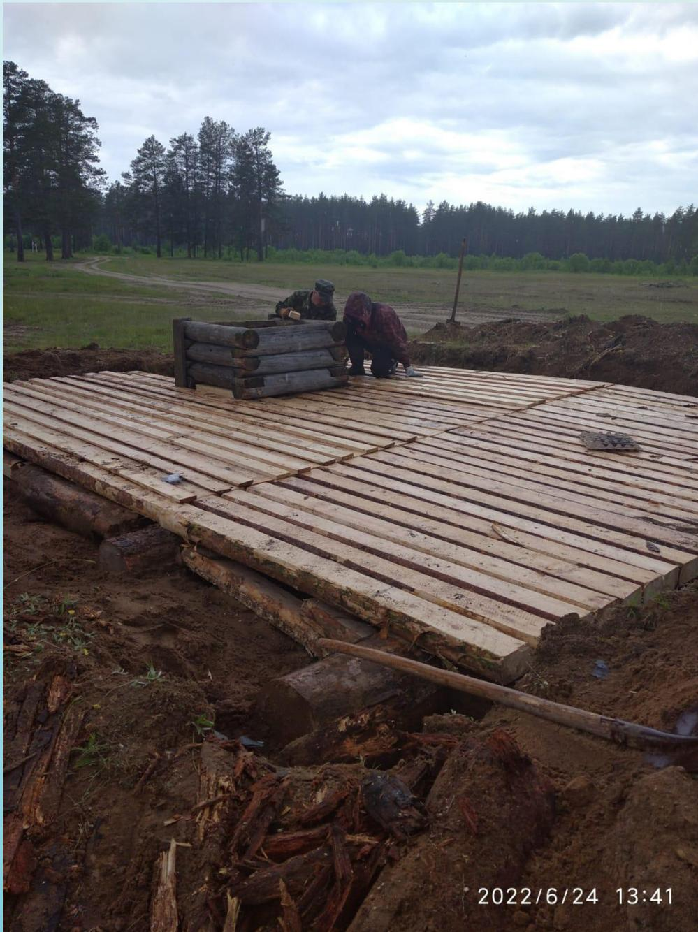
В 2022 году отремонтированы пожарные водоемы: №1 по адресу: п. Кемъяр, ул. Центральная, 13 и №8 по адресу: п. Яснэг, ул. Октябрьская, 1 (замена настила, засыпка грунта, замена горловины), произведен текущий ремонт пожарных водоемов (ремонт внутренних крышек, покраска и ремонт конусов).
