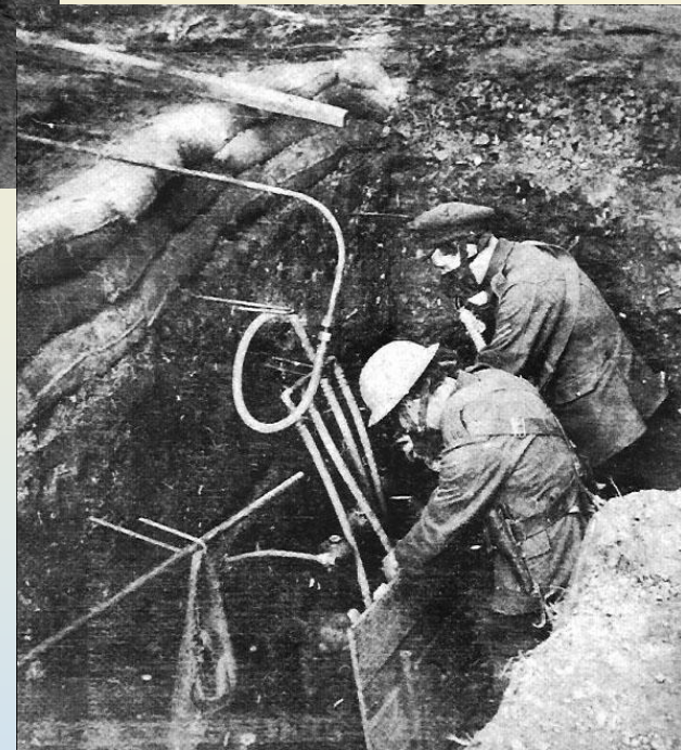
Системы баллонного газопуска
