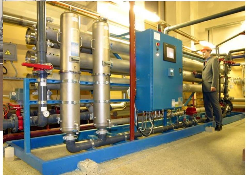
Установка ОО в работе
