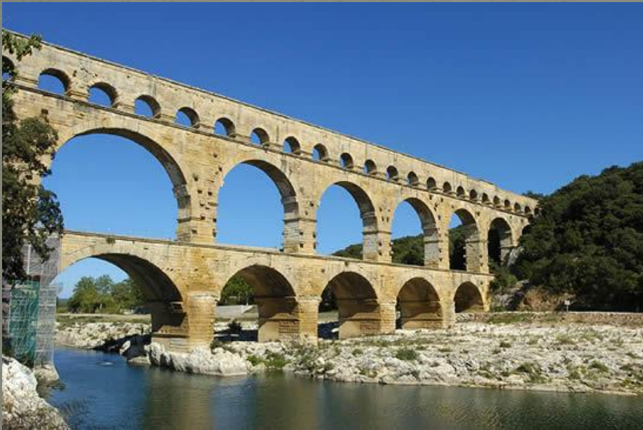
Гарский мост (римский акведук для водоснабжения в Ниме). I в. до н. э. — I в. н. э.
