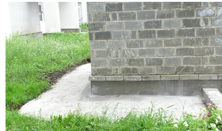
Реконструкция бетонной отмостки вентиляционных шахт
