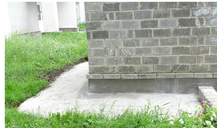
Реконструкция бетонной отмостки вентиляционных шахт
