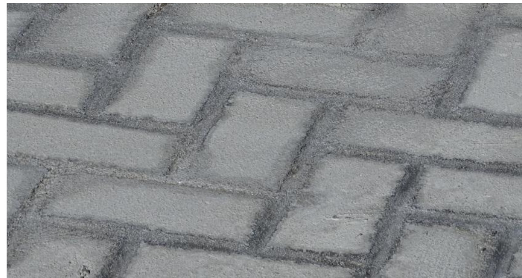
обработано ARENA PolyElast PE в 1 слой
