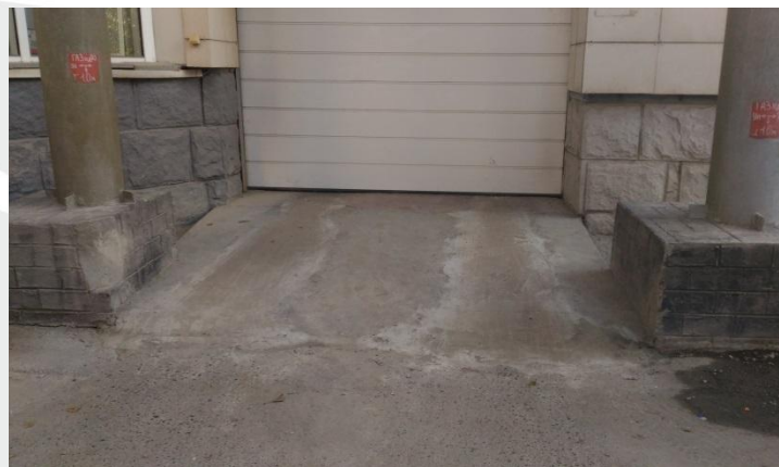
Восстановление покрытия въезда в паркинг
