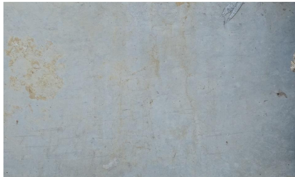
бетон отремонтирован ARENA Repair Master R500
