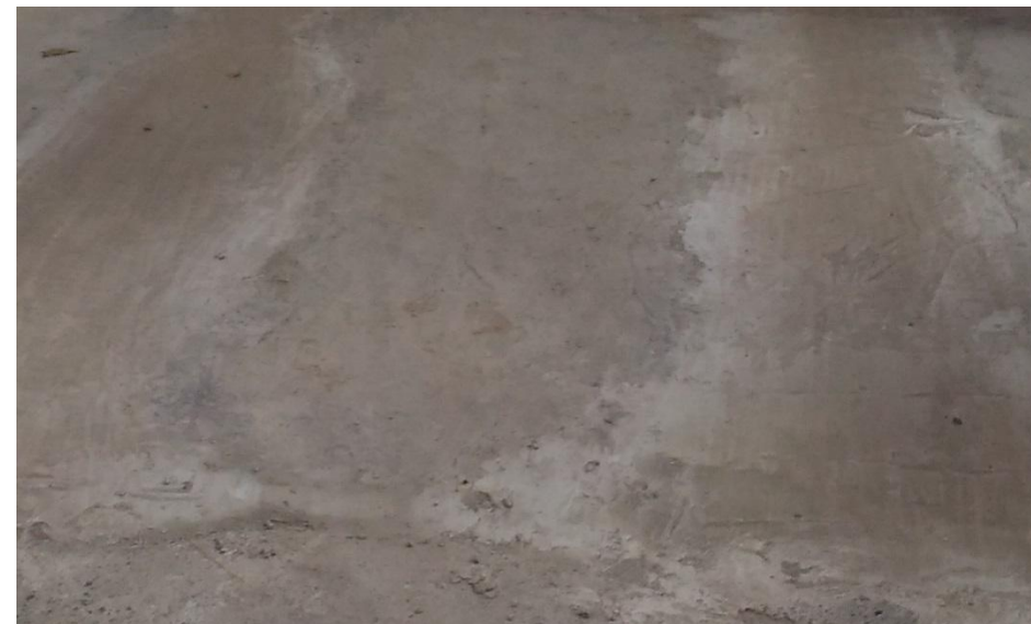
восстановленная поверхность с помощью ARENA Repair Master R300
