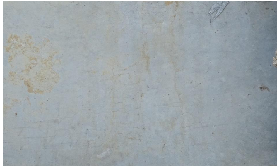
бетон отремонтирован ARENA Repair Master R500
