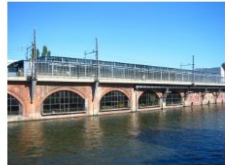
S-BAHNBÖGEN DER JANOWITZBRÜCKE
