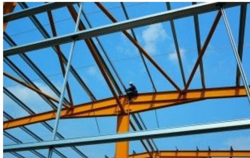
Балки, ригели и фермы наводят на проектные оси до снятия конструкций с крюка крана, по осевым рискам, заранее нанесенным на монтируемые элементы и на колонны поблизости узлов опирания.
