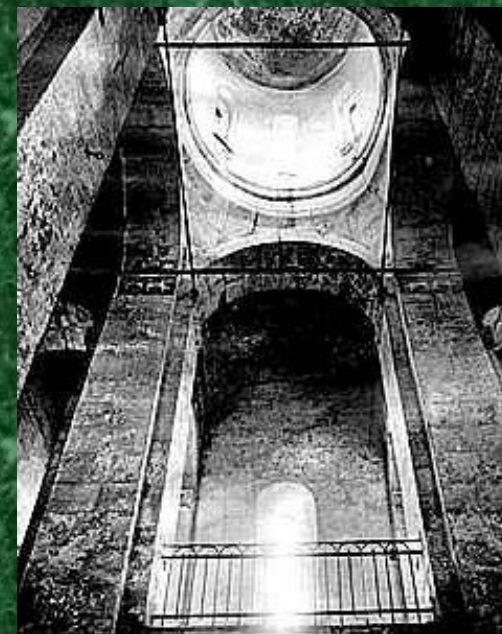
Подкупольное пространство Дмитровского собора
