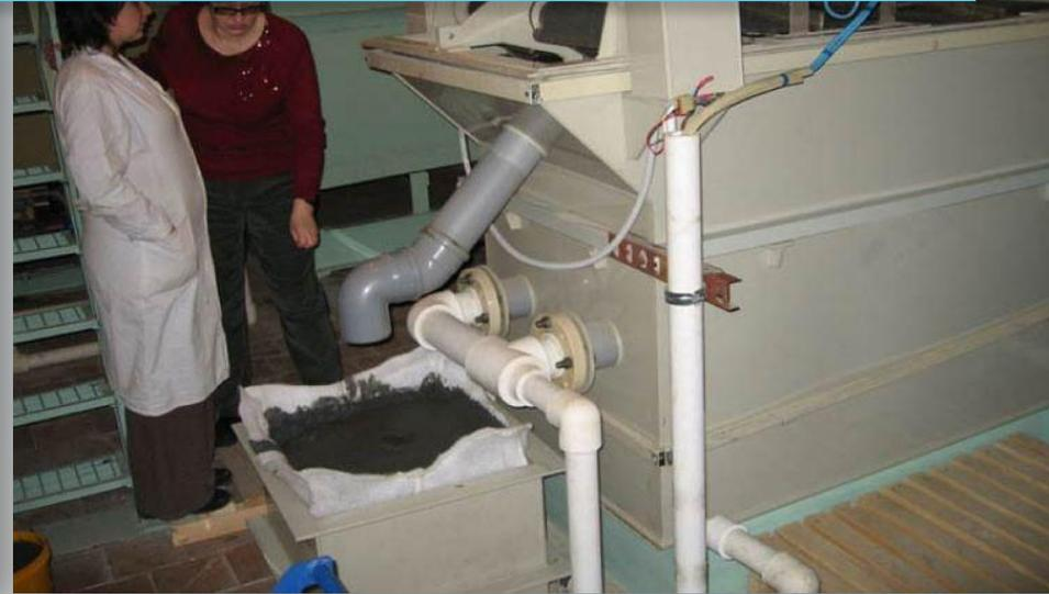
Микрофильтр - промежуточный технологический элемент системы оборотного водоснабжения, обеспечивающий очистку ВОДЫ
