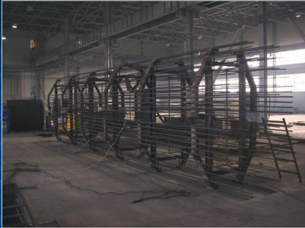
**В массивных железобетонных конструкциях применяется ЖЁСТКАЯ АРМАТУРА – арматурные каркасы, в сборке которых применяют полосовую и профилированную сталь (уголок, швеллер, двутавр...).**
