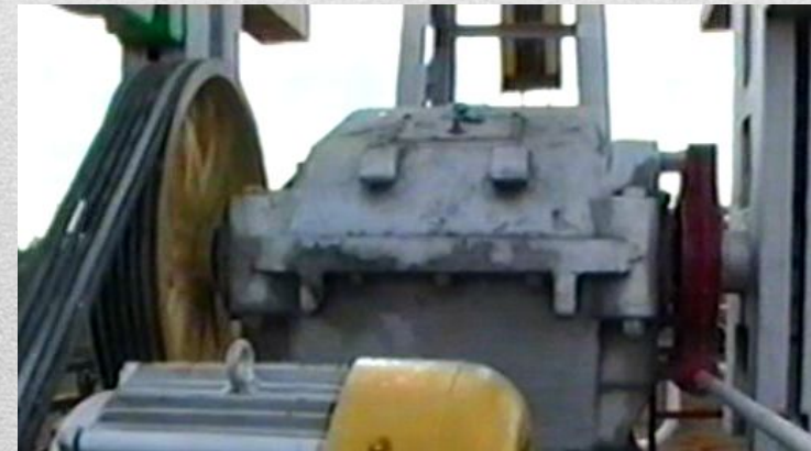
Осмотр редуктора и ременной передачи
