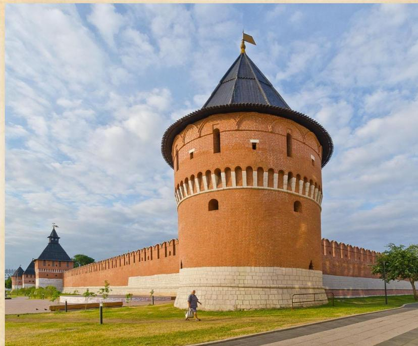
Строительство стен и башен велось на цоколе (нижняя часть строений, лежащая непосредственно на почве), выложенном из блоков белого камня – местного строительного материала, который крестьяне доставляли «вместо иного оброка».
