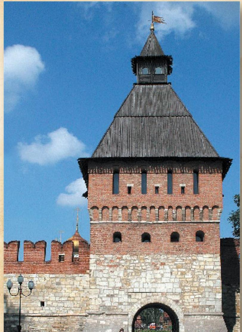
Нижняя часть стен Тульского кремля выложена из белокаменных блоков местного известняка, а выше – из красного кирпича. Завершение стен зубцами в виде ласточкиного хвоста придумали итальянские архитекторы.
