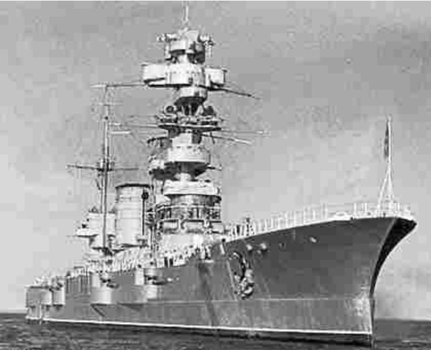
*Линкор «Парижская коммуна» («Севастополь») с носовой наделькой полубачного типа, которая не столько обеспечивала всхожесть на волну, сколько черпала потоки воды на верхнюю палубу, создавая чудовищные продольно-скручивающие нагрузки на корпус.*
