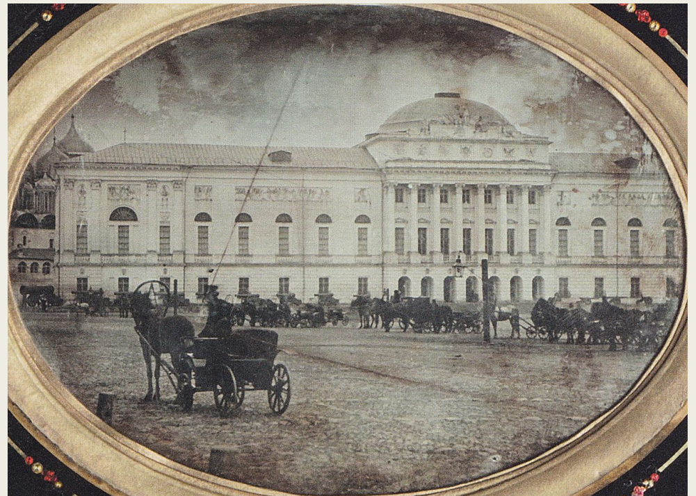
Старое здание Оружейной палаты до перестройки. Единственный дагеротип 1845-1852 года
