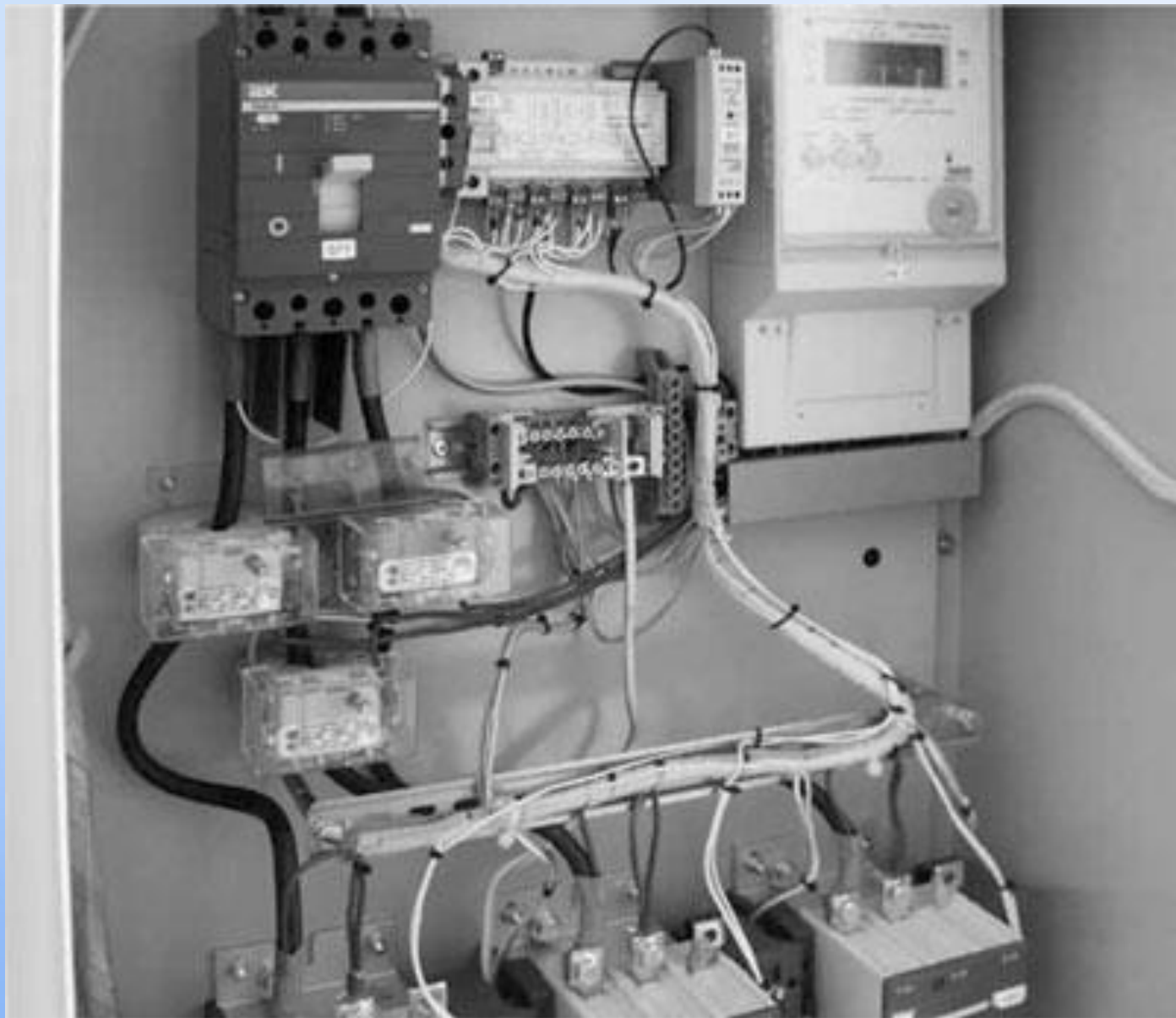
Контроллер AnCom RM/L в составе пункта включения АСУНО
