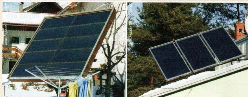
↑ Подобная опорная конструкция нужна для установки коллектора на земле...
