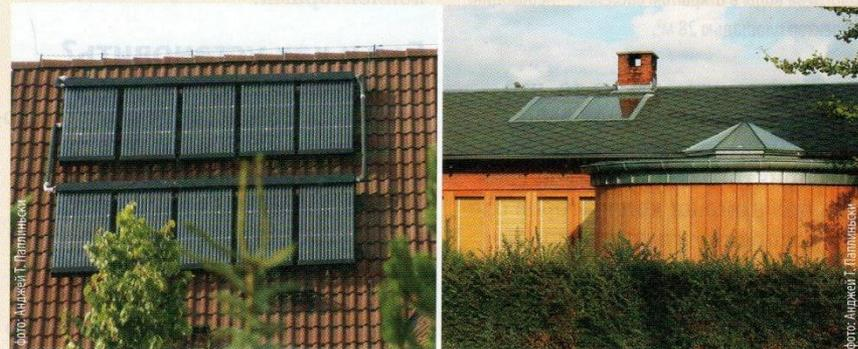
↑ Широко распространено размещение коллекторов на скате крыши. Оно не требует дополнительного места на участке. Коллекторы монтируют над покрытием крыши или как фрагмент покрытия крыши
