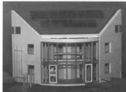
Рис. 4.29. Экспериментальный солнечный дом середины девяностых годов с аккумуляторами (теплоаккумуляторами) в центральной части
