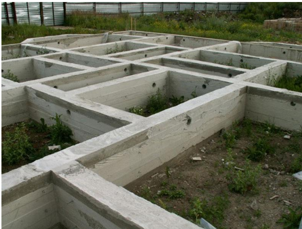
Ленточный фундамент 1,5 м. залегания
