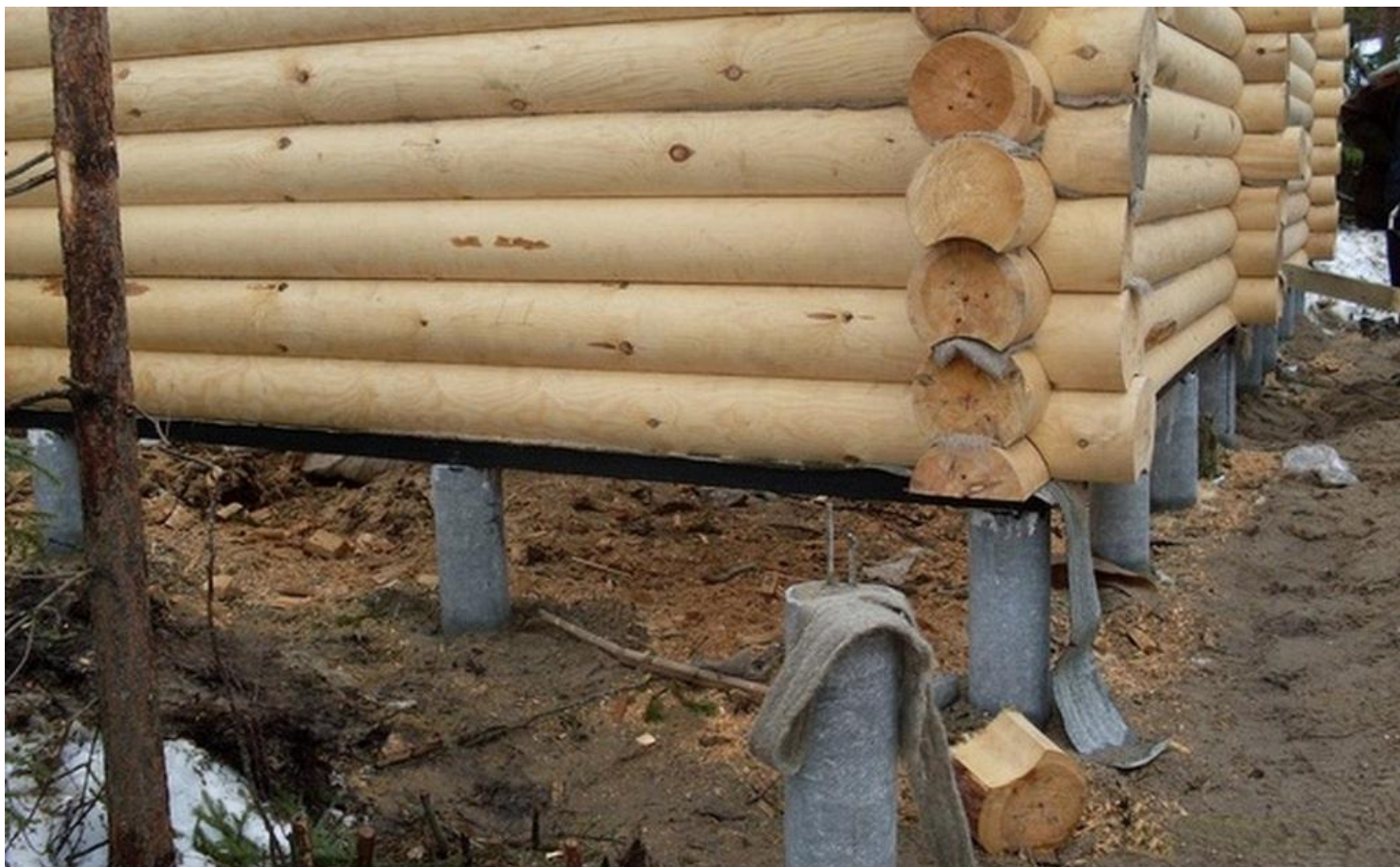
Буронабивные сваи \phi 300 \times 2500
