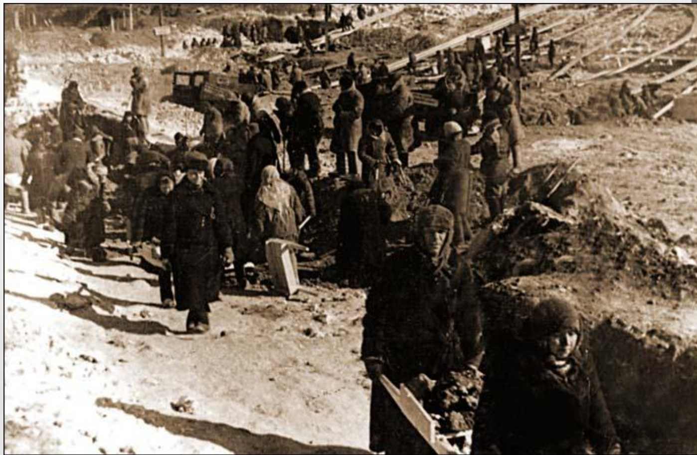
Строительство тракторного завода в Рубцовске
