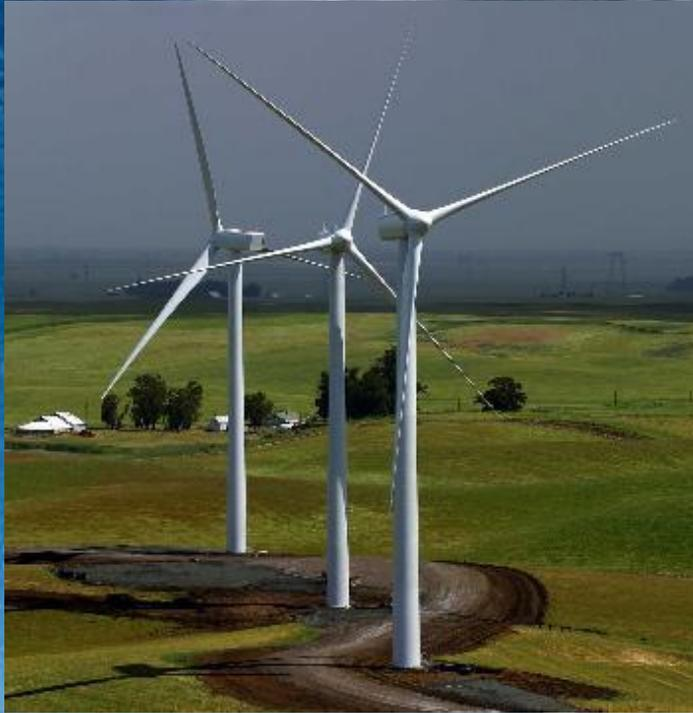
**- это комплекс технических устройств для преобразования кинетической энергии ветрового потока в механическую энергию вращения ротора генератора. ВЭУ состоит из одной или нескольких ВЭС, аккумулирующего или резервирующего устройства и систем автоматического управления и регулирования режимов работы установки.**
