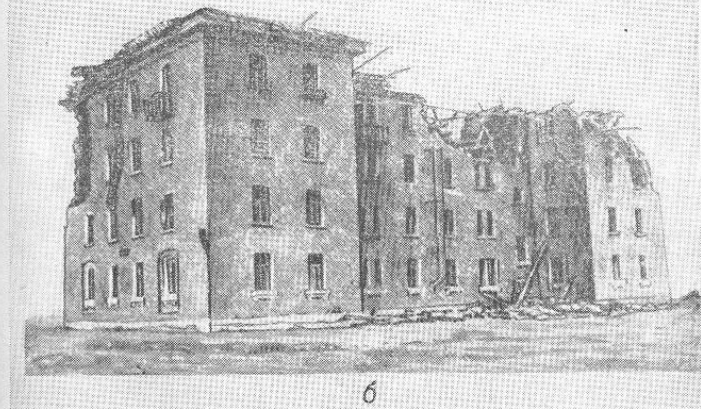
Рис. IV-18. Четырехэтажный кирпичный жилой дом, получивший сильное разрушение: a — до взрыва; б — после взрыва
