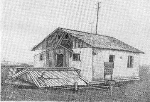
Рис. IV-16. Сборный деревянный жилой дом, получивший слабое разрушение: а — до взрыва; б — после взрыва
