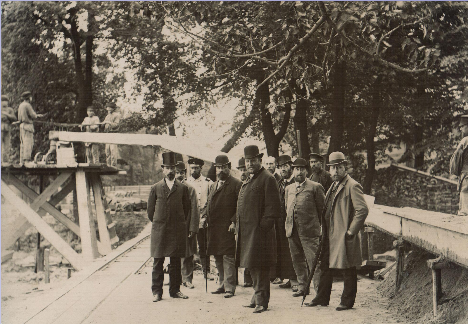
1892г - На строительстве Химической Лаборатории
