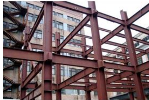
Металлический каркас
