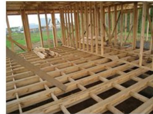
Деревянный каркас
