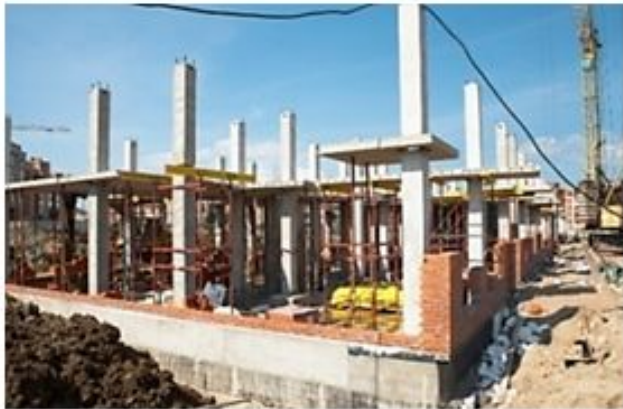
Железобетонный каркас
